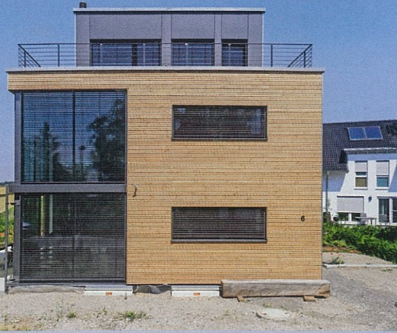
Ein Eyecatcher im Baugebiet ist das dreigeschossige Haus mit Übereck-Verglasung, horizontaler Holz-Lamellen-Verschalung und aufgesetztem Arbeitsbereich.
