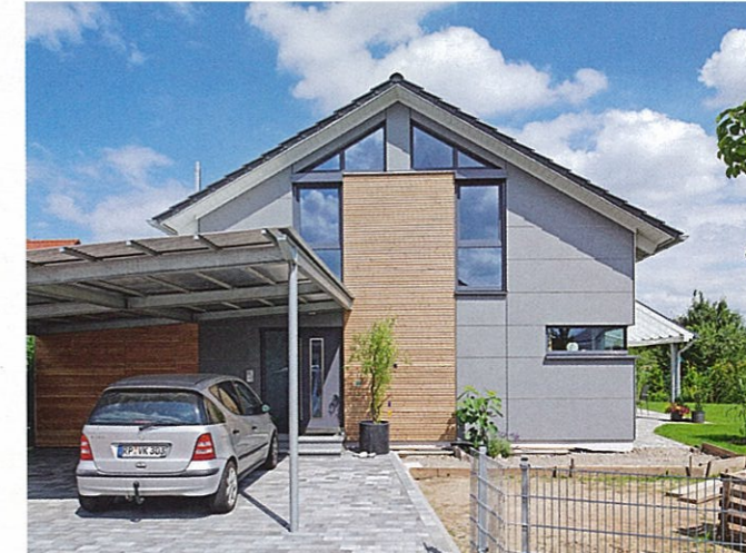
Eine markante Fensteranordnung, Edelstahlschienen an den Hausecken und ein klares Fugenmuster akzentuieren die Fassade.
